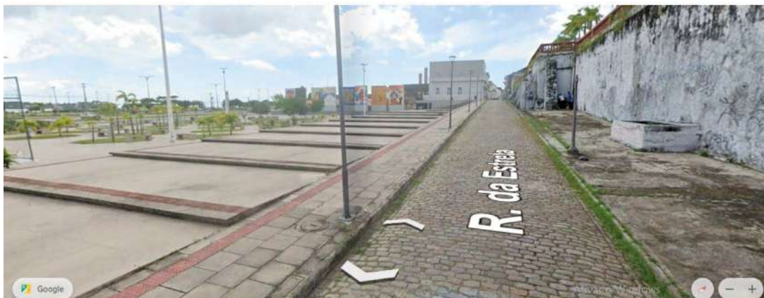
Figura 25: A caixa de concreto à direita, encostada no muro do Convento das Mercês, esconde a história da Pocinha. Onde atualmente é a Praça das Mercês, antes era a saudosa Praia do Desterro. Fonte: Google Street View (maio de 2025).
