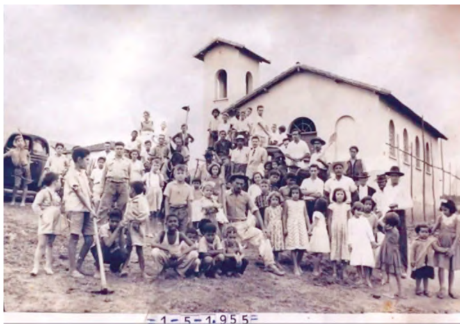
Figura 130: Foto da festa do 1o de maio, em 1955, na qual se constata a capela inicial já construída. Percebe-se que a capela tinha sua fachada voltada para oeste, para o miolo do bairro Vila Esperança.
