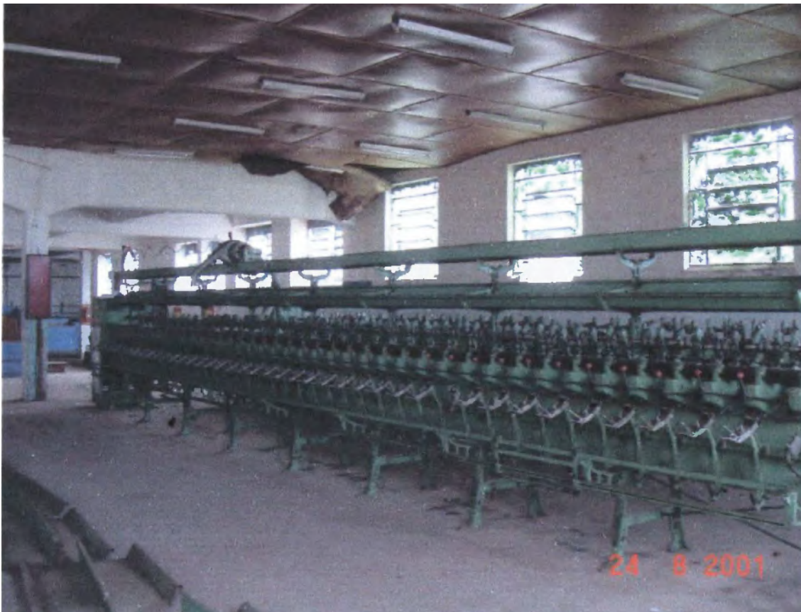
Figura 102: Espuladeira da Fábrica São Martinho, já desativada. Fonte: Processo de tombamento, Condephaat, 2001.
