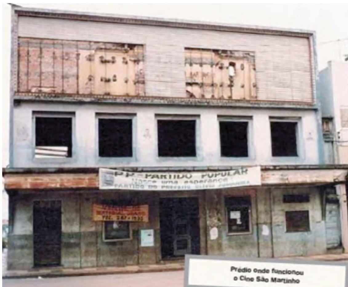
Figura 141: Cine São Martinho logo antes da demolição. Fonte: Voz da História, 2018.
