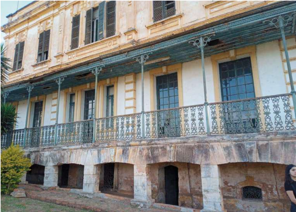
Figura 113: Detalhe da fachada lateral, e o uso de material em ferro fundido como guarda-corpo e estrutura da cobertura da varanda.
