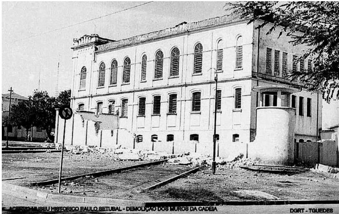
Figura 125: Demolição em 1970, das estruturas de muros de fechamento e guarita de vigilância. Fonte: Vianna e Barros, 2020.
