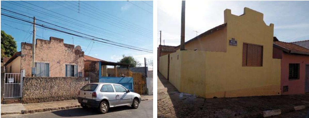
Figura 80 e 81: Diferentes padrões de construção das casas operárias na Vila Esperança. Fonte: Simone Scifoni, 2023.
