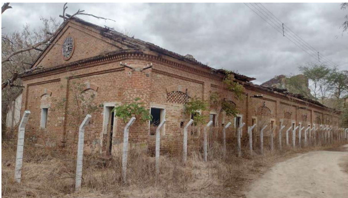
Figura 61: Galpão do DNOCS conhecido como “vilinha”, Quixadá-CE.
