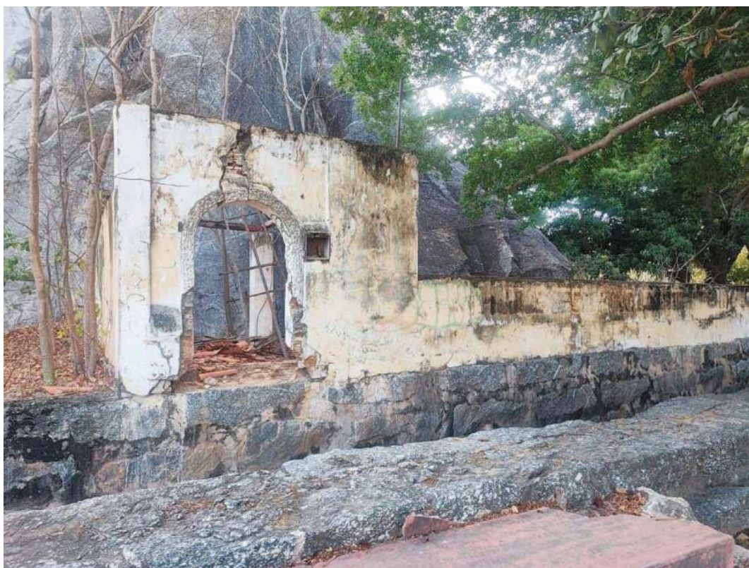
Figura 44: Entrada do antigo balneário do DNOCS, Quixadá-CE.
