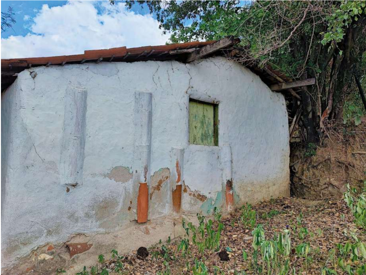
Figura 51: Aspecto da fachada lateral de casa de taipa na Comunidade Cedro Novo, Quixadá-CE. Autoria: Mateus Pinheiro, 2024.
