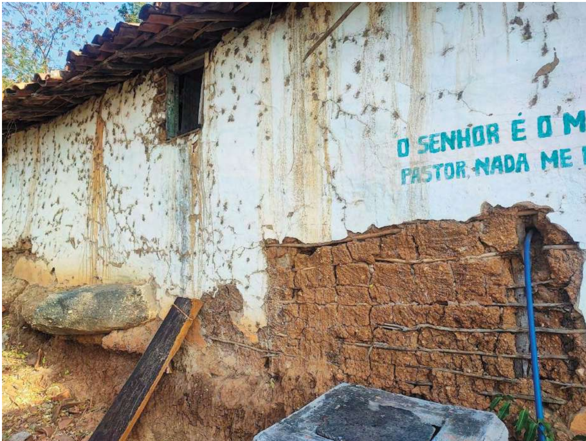
Figura 22: Detalhe da parede de uma casa de taipa, na comunidade Cedro Novo, Quixadá- CE. Autoria: Mateus Pinheiro, 2024
