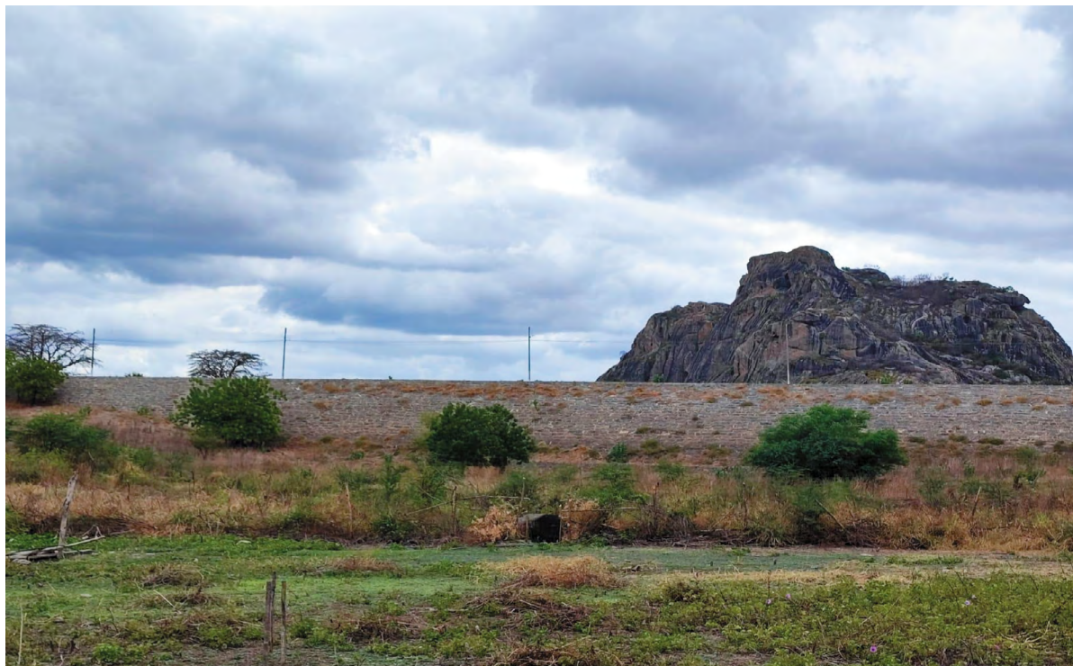
Figura 56: Parede Seca (Barragem Sul,) Cedro Novo, Quixadá-CE.
