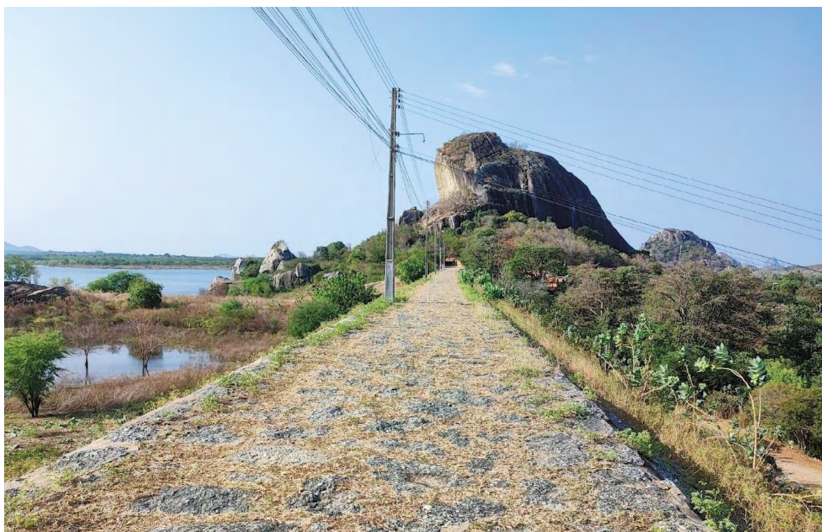
Figura 57: Parede Seca (Barragem Sul,) Cedro Novo, Quixadá-CE.
