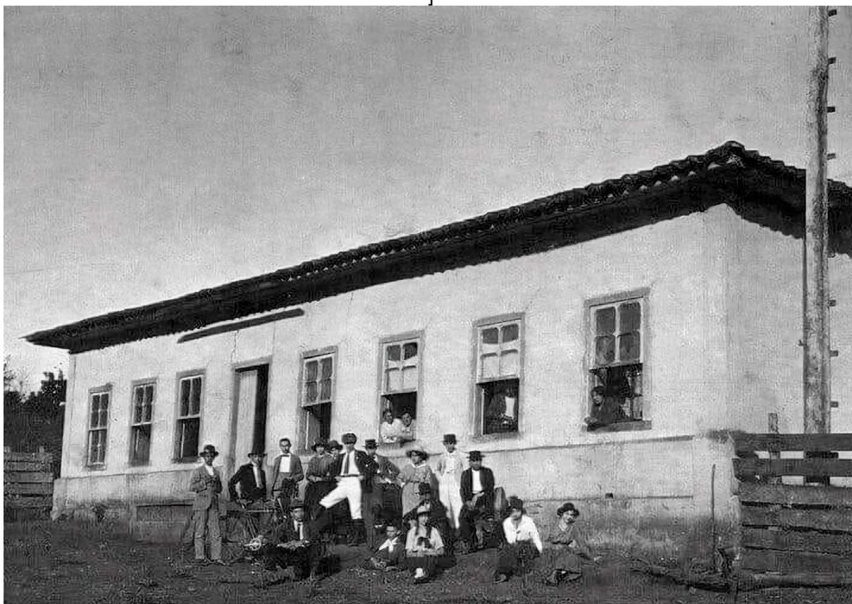
Figura 87: Casarão do Coca, onde funcionava a escola.
