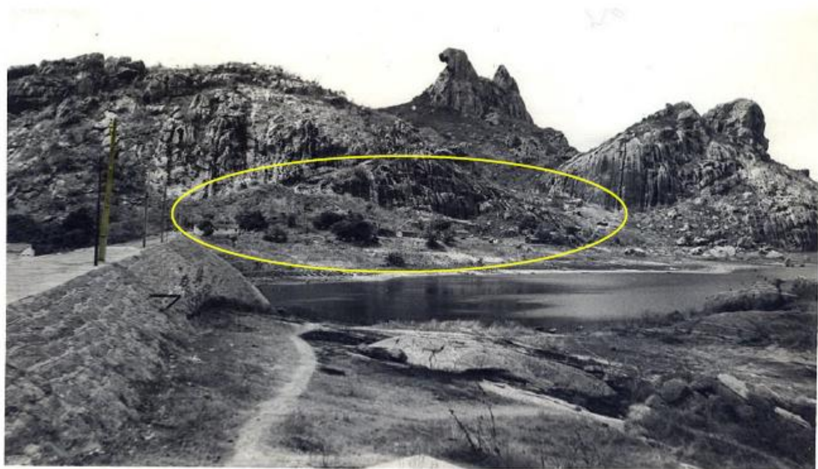
Barragem austral (auxiliar) vista de montante. Ao fundo pedra da Galinha Choca.
